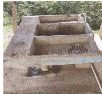
Foto 4: Sustitución de Pileta
