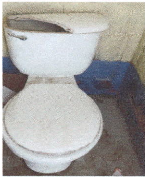
Foto 3: Sustitución de 3 Tazas y un Lavamanos
