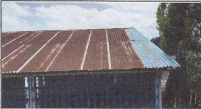
Foto 1: Entechado de Aulas Módulo 1, 3 Aulas
